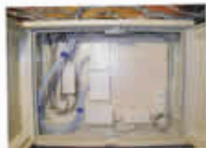
LANケーブルは一般的に電力ケーブルや分電盤の近くに配線するとノイズを受けやすくなるので、できるだけ離す。ユニットバスの点検口の近くなども湿気の影響を受けやすいので、換気扇設置の設置には不適切。
